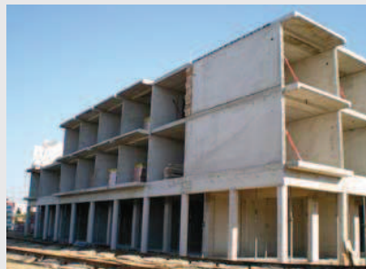
Ściany zewnętrzne i wewnętrzne wykonane z elementów prefabrykowanych systemu WK-70 BOGUCIN
